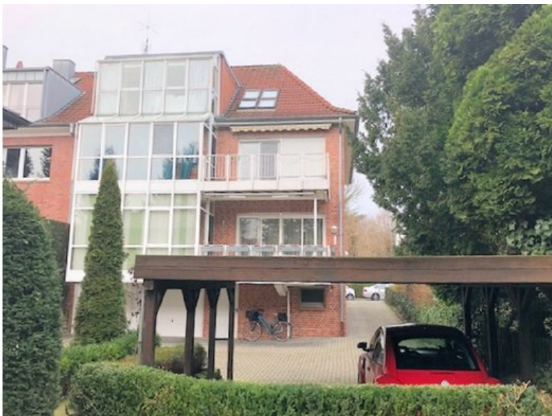
Blick auf den Wintergarten mit Balkon
