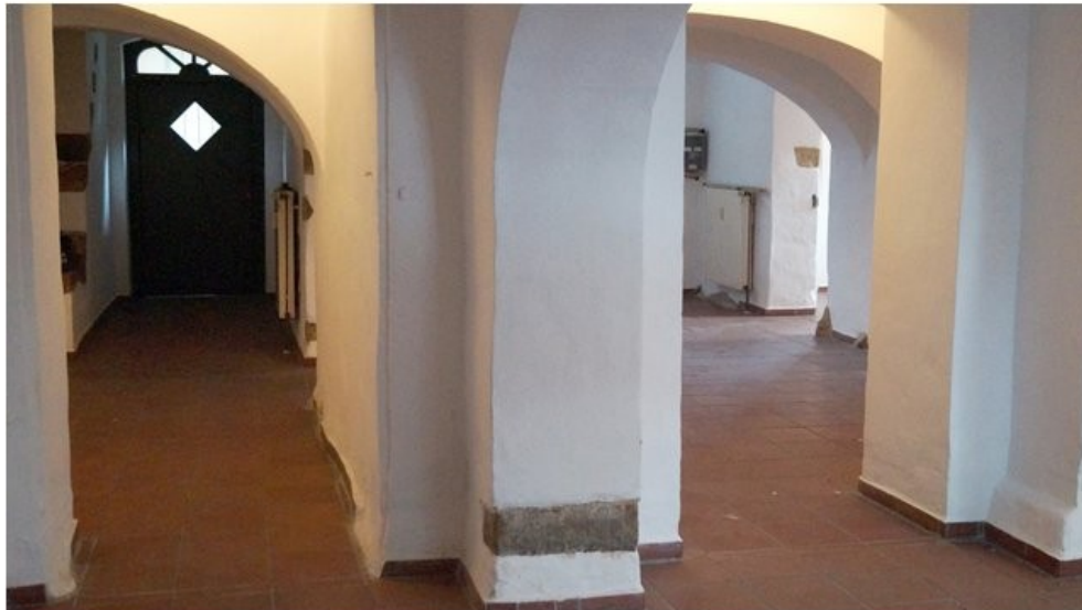
Eingang und Vorraum
