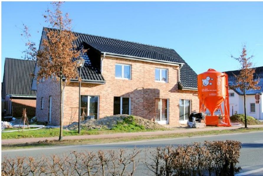
Blick von der Straße
